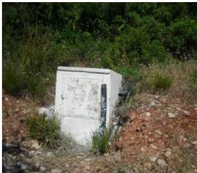
En el afloramiento, existe una pequeña caseta, en la que se realiza la toma del agua para abastecimiento, mediante una tubería de PE de 50 mm
