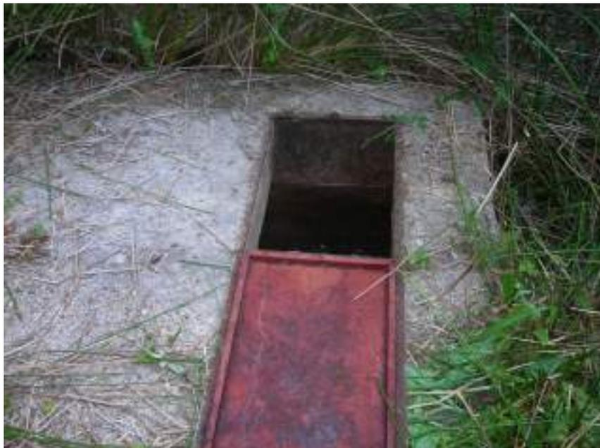
En la arqueta se realiza la toma de una porción del agua para abastecimiento, mediante una tubería de P.E. de 50 mm. de diámetro. El resto del agua del manantial vierte al arroyo.
