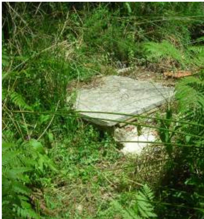
En el afloramiento, existe una pequeña arqueta, en la que se realiza la toma del agua para abastecimiento, mediante una tubería de PE de 40 mm
