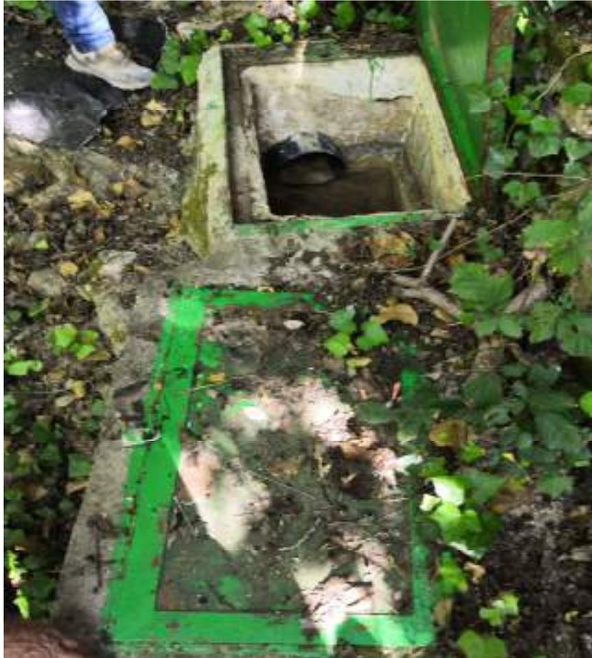
En el afloramiento, existe una arqueta doble, en la que se realiza la toma de una porción del agua para abastecimiento, mediante una tubería de PE de 63 mm de diámetro. El resto del agua del manantial es empleada para riego o vertida a una al manantial.
