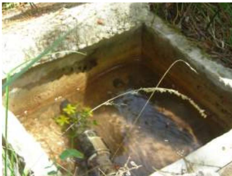
En el afloramiento, existe una arqueta, en la que se realiza la toma de una porción del agua para abastecimiento, mediante una tubería de PE de 32 mm. En la parte del manantial y tubería de 50 mm de diámetro en la parte del depósito. El resto del agua del manantial es empleada para riego o vertida a una acequia.
