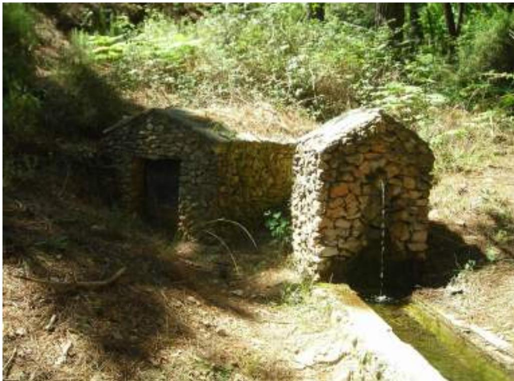
En el afloramiento, dentro de la caseta, existe una arqueta, en la que se realiza la toma de una porción del agua para abastecimiento, mediante una tubería de PE de diámetro 40 mm. El
