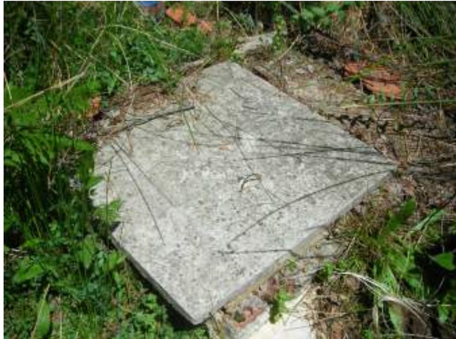
En el afloramiento, existe una arqueta, en la que se realiza la toma del agua para abastecimiento, mediante una tubería de PE de diámetro 40 mm. de 137 ml de longitud, que conduce el agua hasta un depósito.
